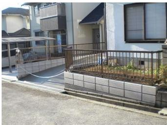
既存のブロックの上に積む箇所と新規にブロック積みする箇所がありました。いずれも立と横方向に鉄筋を入れ、ブロックを一体化させ強度を上げます。
